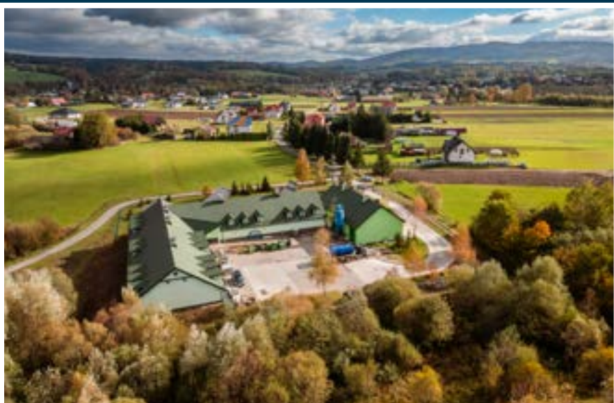
Oczyszczalnia ścieków w Stróżach
