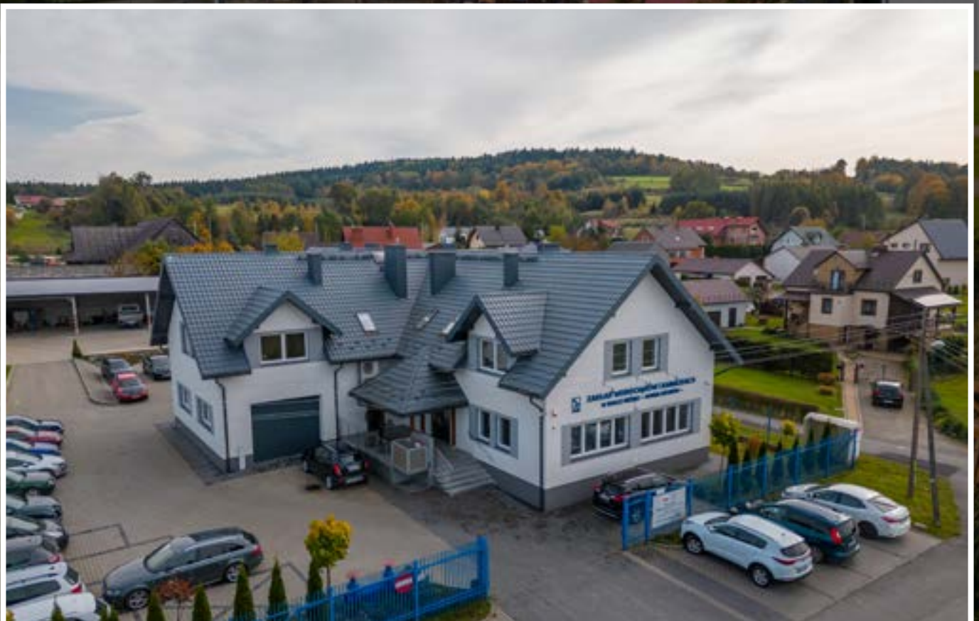
Zakład Wodociągów i Kanalizacji w Białej Niżnej
